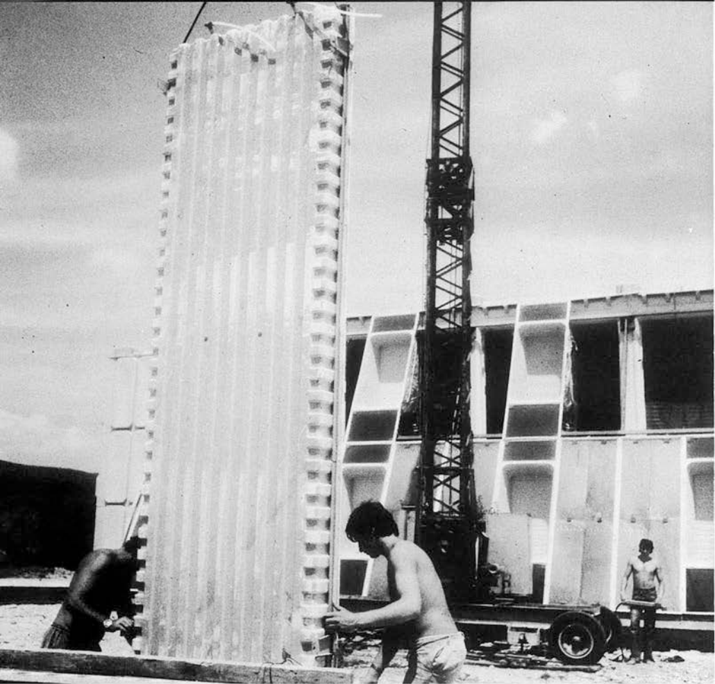
Uno dei grandi pezzi possibili con la formatura sottovuoto. Si tratta del contenitore di un collettore solare, sistemato sulla facciata della scuola di Nera Montoro. Progetto Arch. Mario Scheichenbauer.
