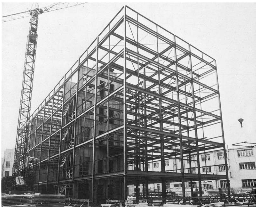
La struttura metallica e i blocchi scale servizi.
