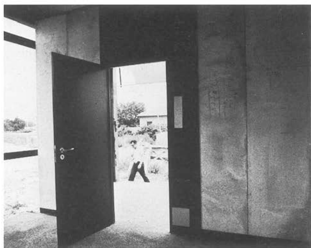
Sistemazione della porta prefabbricata nel modello. Sulla parete vicino alla porta si nota uno schizzo di probabile variante della sistemazione della porta.
