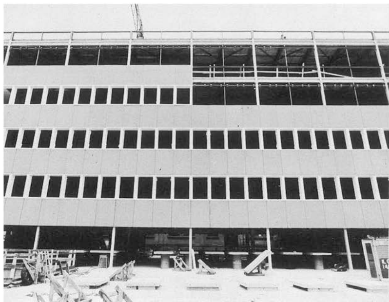
La sistemazione del terminale di copertura.
